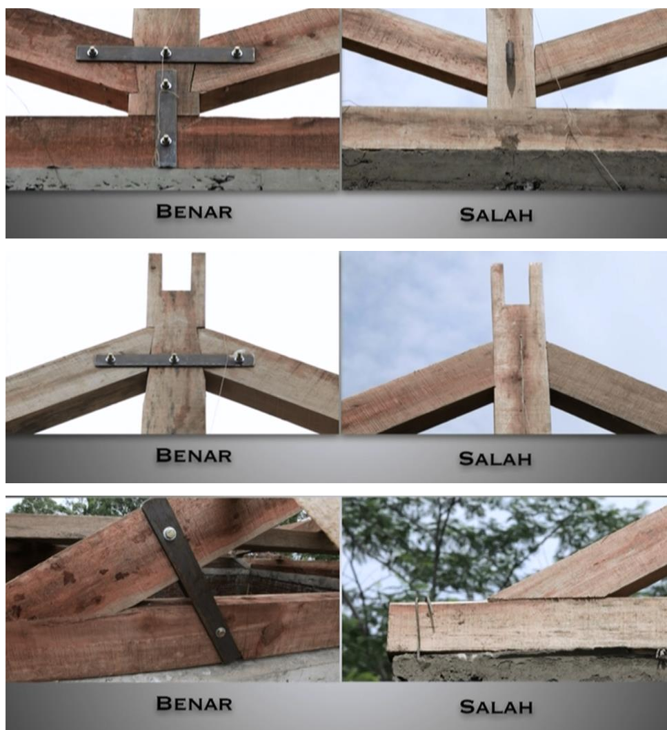
Gambar 29. Pemasangan Plat Baja Pada Kuda-kuda Kayu
