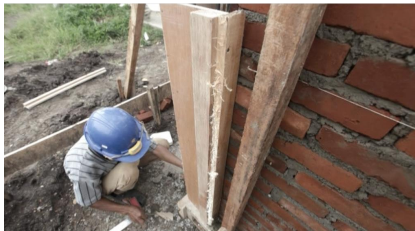
Gambar 55. Pemasangan Cetakan/ Bekisting Untuk Kolom
