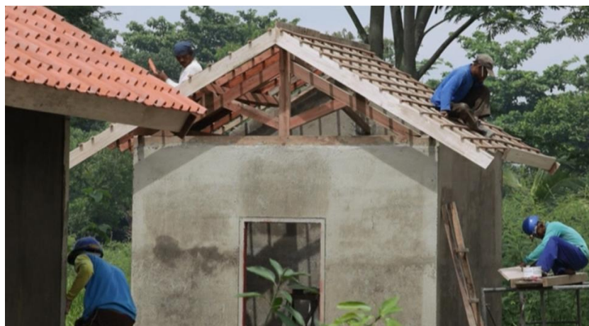
Gambar 27. Kuda-kuda Kayu Pada Atap Rumah Tinggal
