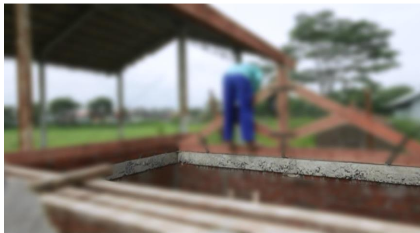
Gambar 22. Balok Keliling/ Ring
