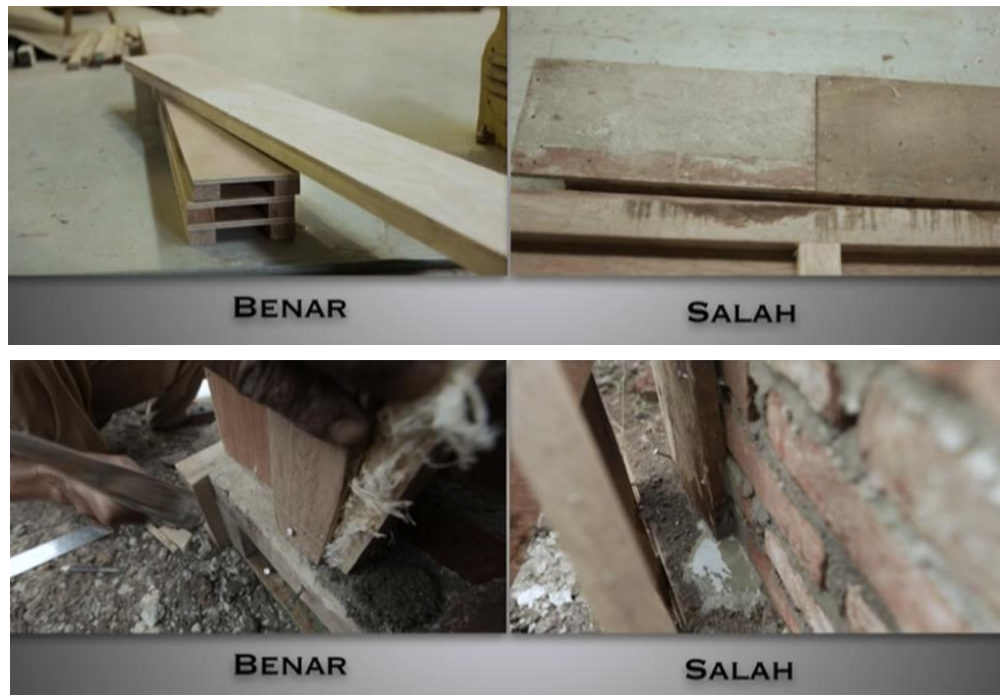
Gambar 54. Kualitas Cetakan/ Bekisting
