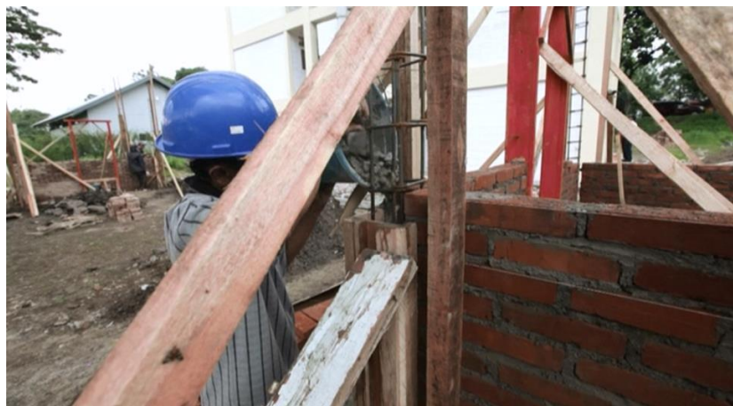
Gambar 56. Proses Pengecoran Kolom
