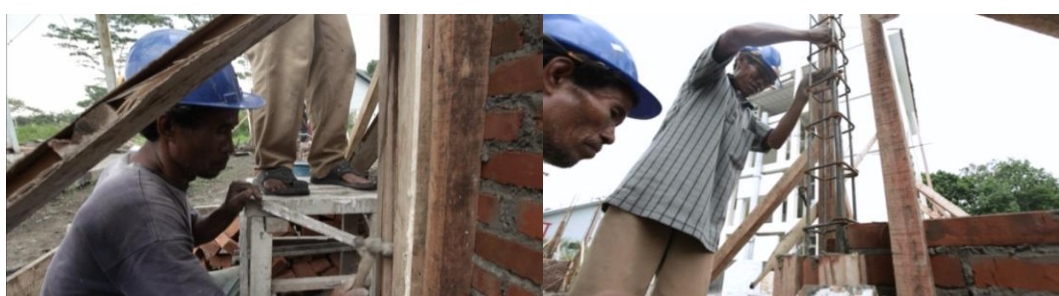
Gambar 57. Pemadatan Beton Dengan Memukul-mukul Cetakan/ Bekisting dan Campuran Beton Dirojok Menggunakan Besi atau Bambu
