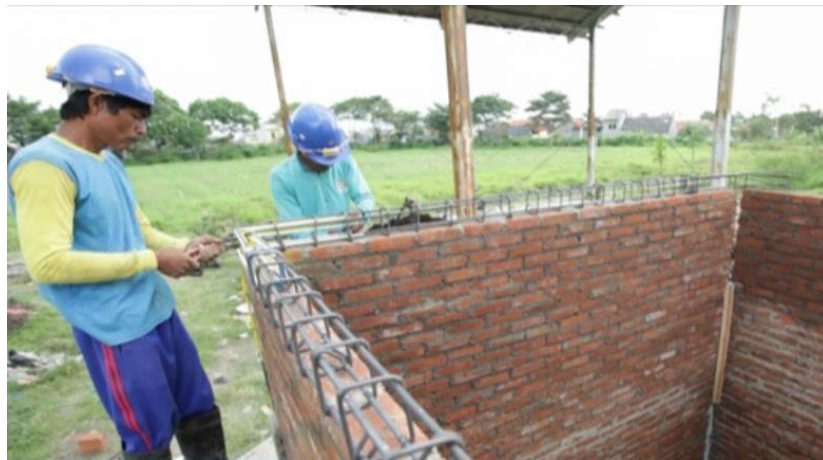
Gambar 58. Pengecoran Balok Pengikat/ Sloof
