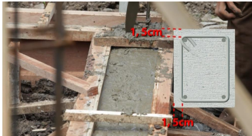
Gambar 19. Balok Pengikat/ Sloof
