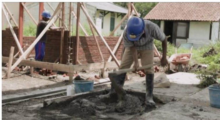
Gambar 8. Proses Pencampuran Mortar
