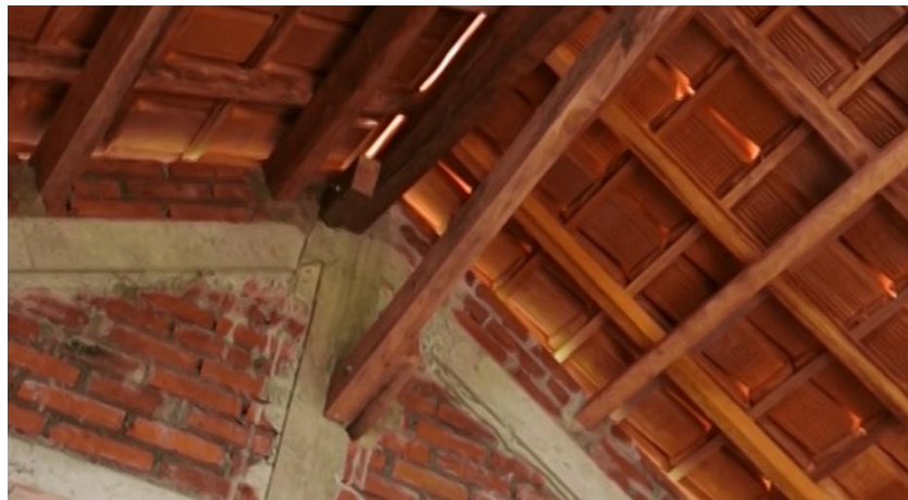
Gambar 37. Pertemuan Antara Ikatan dengan Gunung-Gunung/ Ampig
