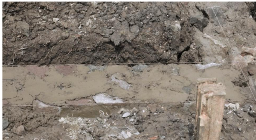
Gambar 11. Pondasi Dari Batu Kali/Gunung
