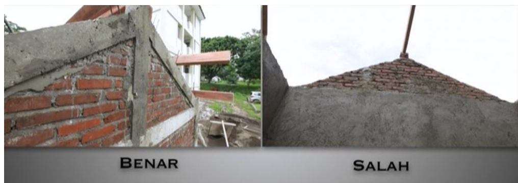
Gambar 32. Gunung-Gunung/ Ampig
