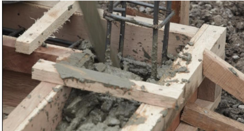
Gambar 58. Pengecoran Balok Pengikat/ Sloof
