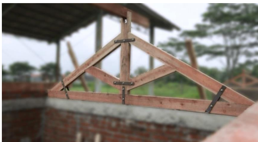
Gambar 28. Kuda-kuda Kayu Dengan Pengikat Plat Baja
