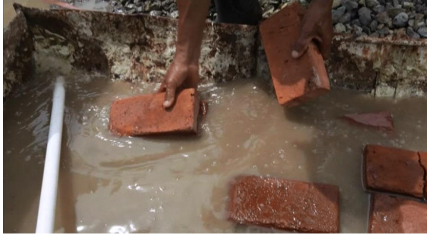
Gambar 15. Perendaman Batu Bata Sebelum Dipasang
