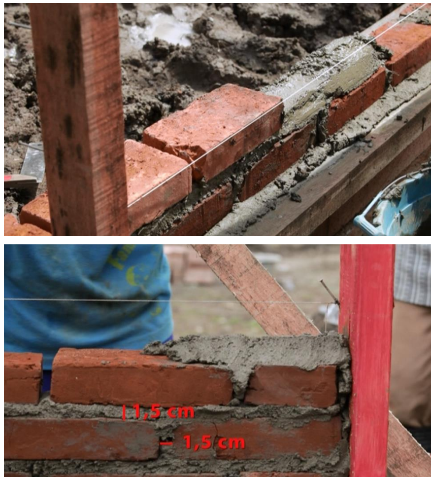
Gambar 41. Proses Pemasangan Batu Bata Untuk Dinding
