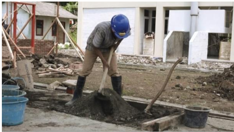
Gambar 7. Bahan Campuran Mortar
